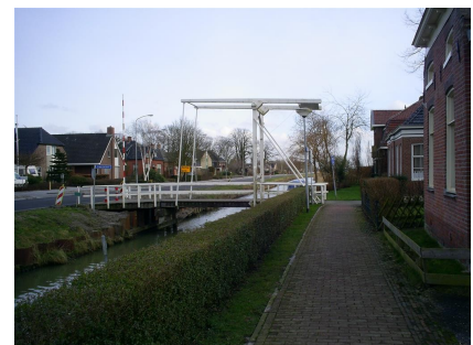
Over de brug rechts
