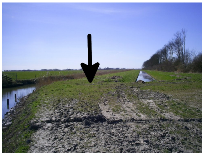
Na het gemaal via een dijkje
